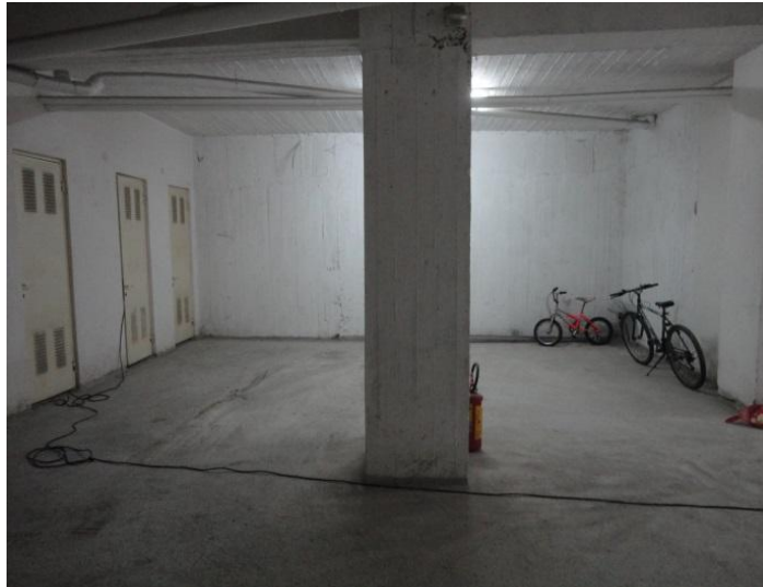
Εικόνα[27] Χώρος στάθμευσης αυτοκινήτων, οπτική β.
