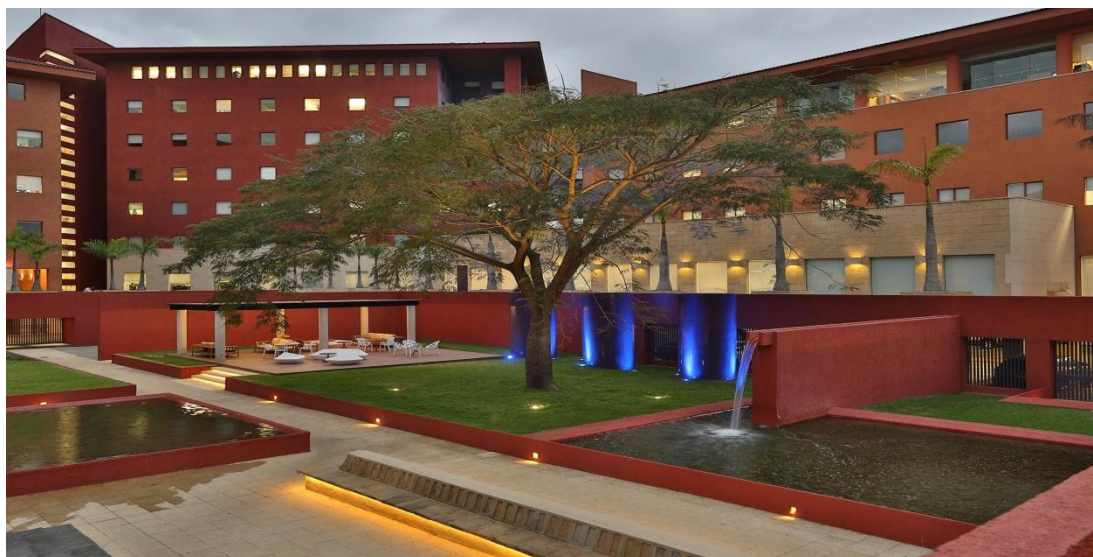
Σχήμα No.20: Συγκρότημα Plaza Robles όπου κάτω από το σιντριβάνι που διακρίνεται είναι τοποθετημένο το σύστημα αποθήκευσης πάγου.
