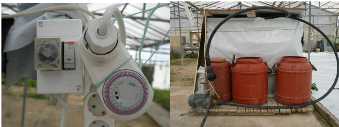
Εικόνα 4.6. (Αριστερά), Χρονοδιακόπτης. (Δεξιά), νεπόζιτο, αντλία, Δοχεία με θρεπτικά διαλύματα A - \text{Ca}(\text{NO}_3)_2 , \text{KNO}_3 , \text{NH}_4\text{NO}_3 , \text{Fe} . B - \text{KNO}_3 , \text{MgSO}_4 , \text{Mg}(\text{NO}_3)_2 , \text{K}_2\text{SO}_4 , \text{H}_3\text{PO}_4 , \text{MnSO}_4 , \text{ZnSO}_4 , \text{CuSO}_4 , \text{H}_3\text{BO}_3 , (\text{NH}_4)_6\text{Mo}_7\text{O}_{24} , C - \text{HNO}_3 .
