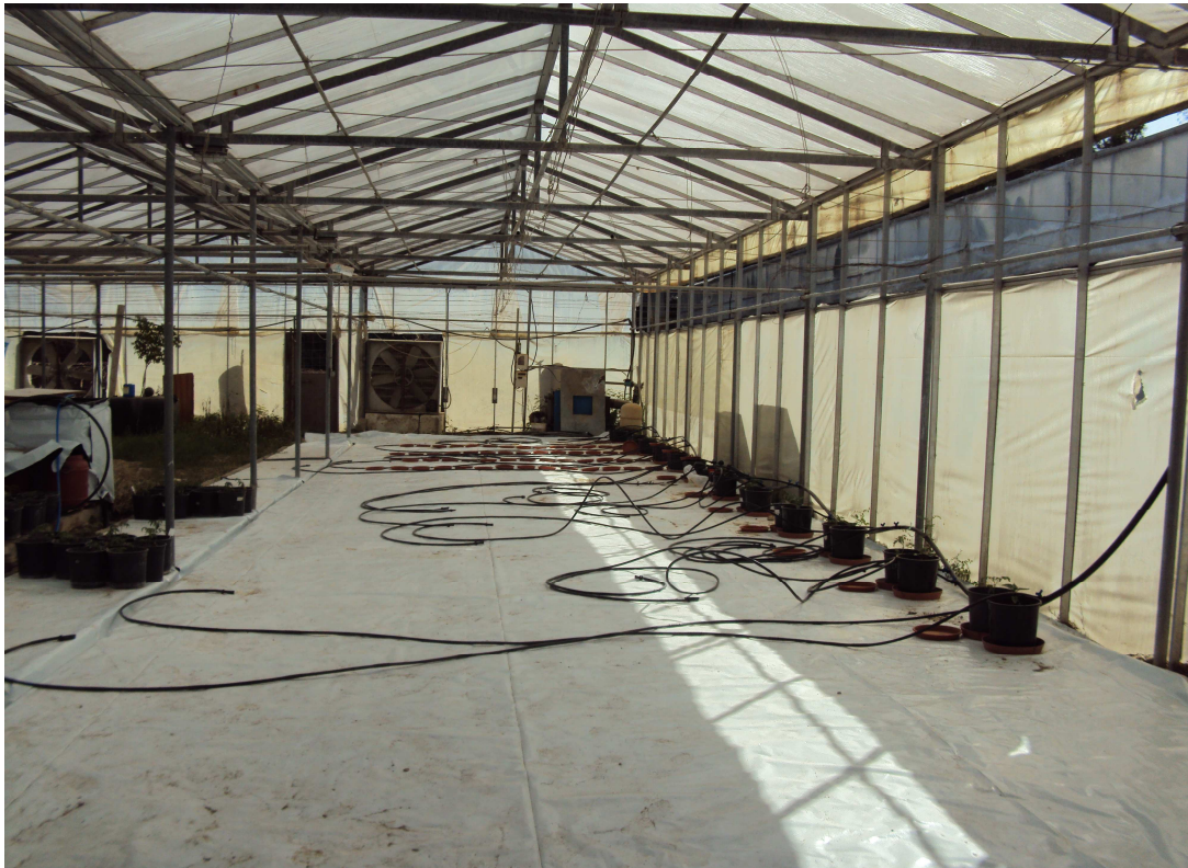
Εικόνα 4.9: Εγκατάσταση αρδευτικού δικτύου.
