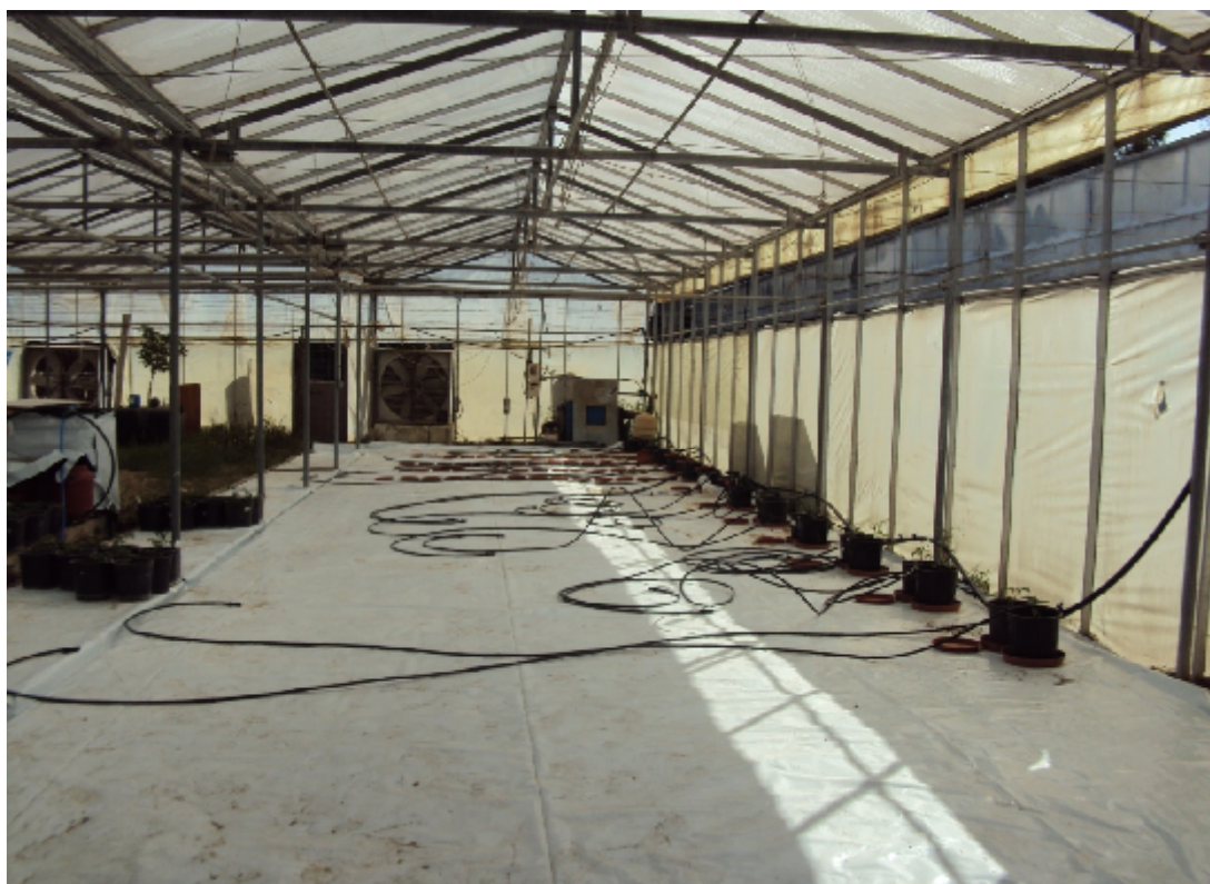
Εικόνα 4.10: Εγκατάσταση αρδευτικού δικτύου
