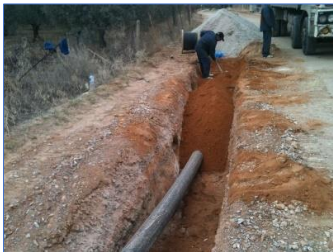
Εικόνα 3.2: Χαντάκι αγωγού μεταφοράς νερού
