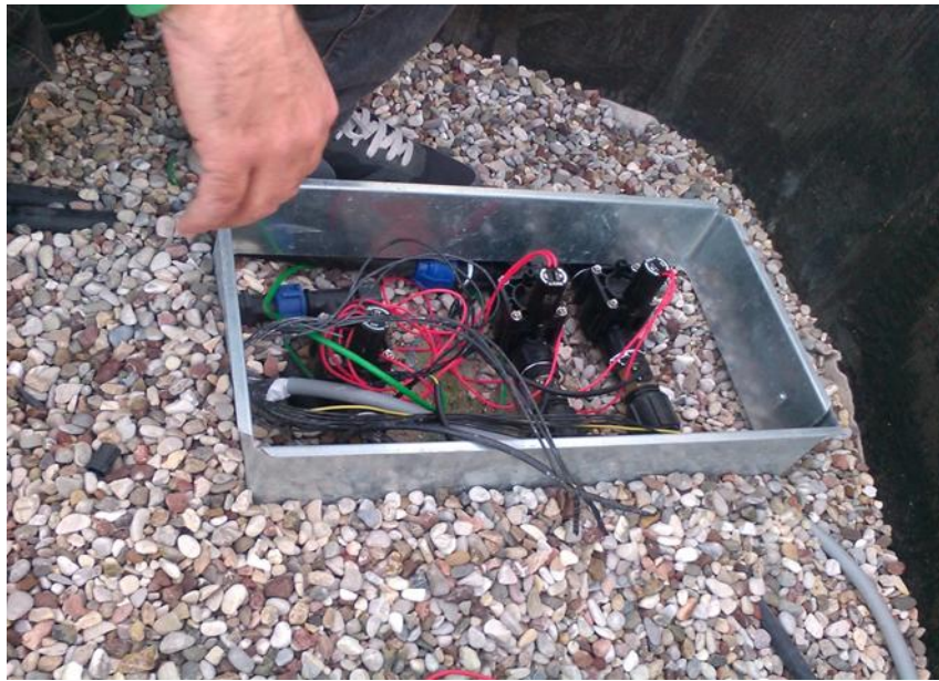
Εικόνα 3.11 Ηλεκτροβάνες και ροόμετρα του ταρατσόκηπου
