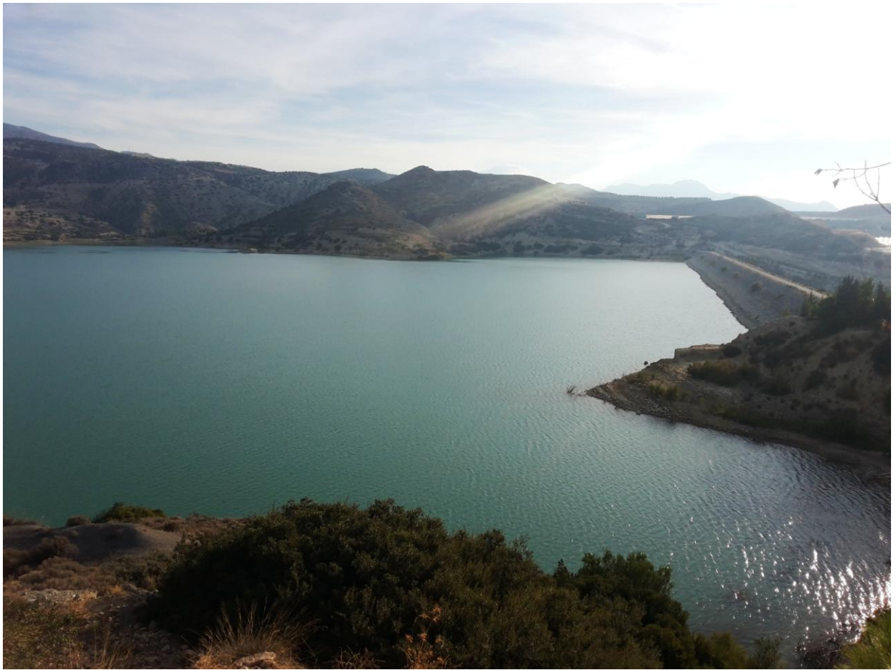
Εικ. 4.4: Δυτική πλευρά του Φράγματος
