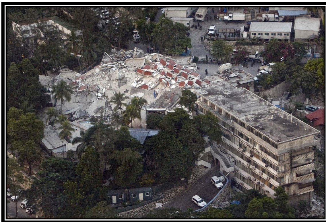
Εικόνα 1.1 Χαρακτηριστικό καταστροφικό αποτέλεσμα σεισμού σε κτιριακή δομή [1]
