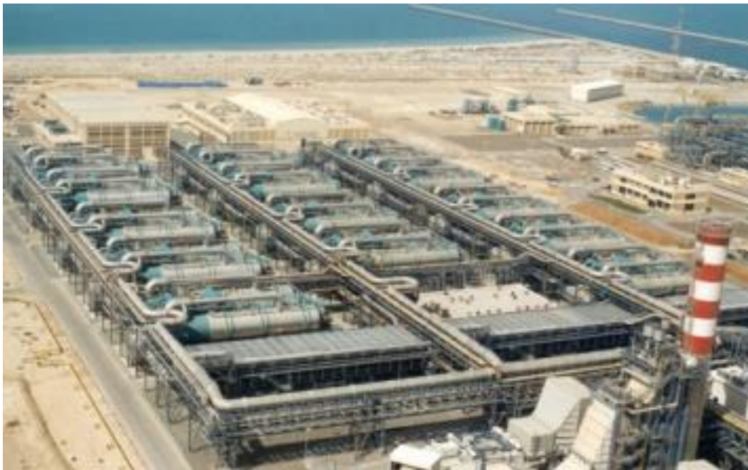
Εικόνα 11 : Εγκατάσταση MSF στη Σαουδική Αραβία.[8]
