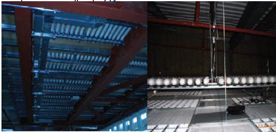
Εικόνα 19 Σωλήνες οροφής εμπλουτισμένοι με υλικά αλλαγής φάσης
