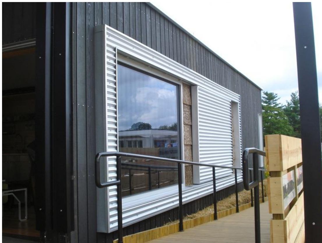
Εικόνα 10 Trombe wall με υλικά αλλαγής φάσης
