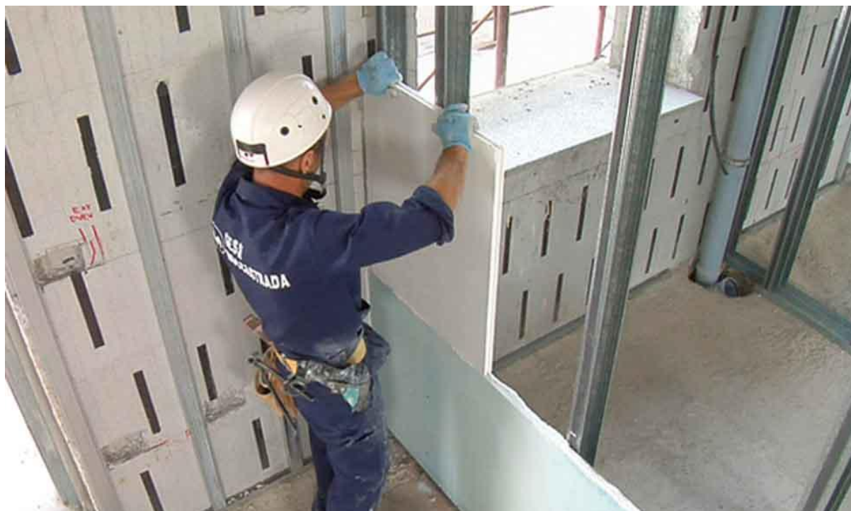
Εικόνα 12 Ανακαίνιση σπιτιού με γυψοσανίδες εμπλουτισμένες με υλικά αλλαγής φάσης
