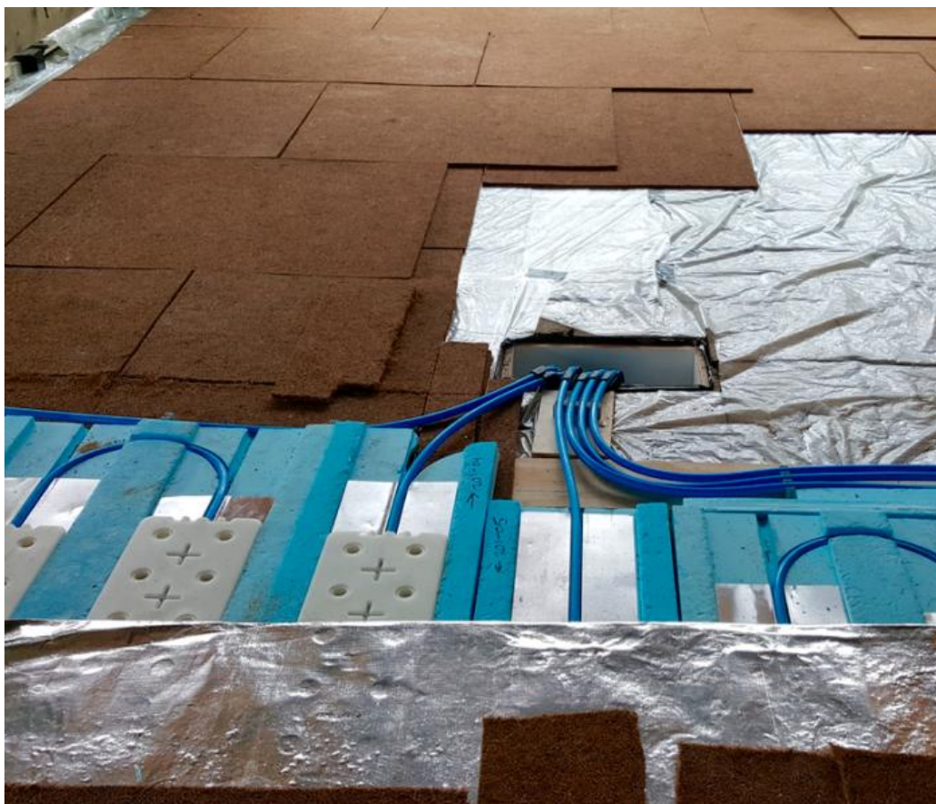
Εικόνα 17 Ενδοδαπέδια με υλικά αλλαγής φάσης
