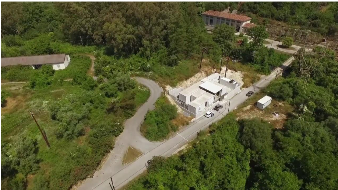
Εικόνα 11 Αεροφωτογραφία του κέντρου δεδομένων της ΕΔΕΤ δίπλα στο φράγμα του Λούρου
