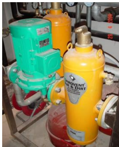
Εικόνα 36 : Απαερωτής-διαχωριστής σωματιδίων (δεξιά), κυκλοφορητής (αριστερά) και Κ.Δ.Δ. (κάτω)
