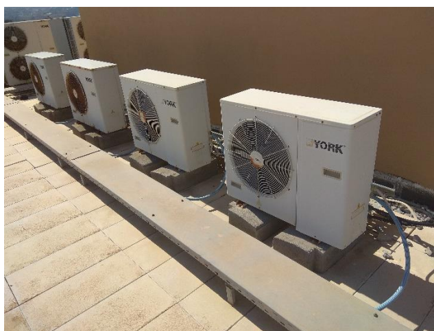
Εικόνα 171 : Συστοιχία των μονοφασικών αντλιών θερμότητας
