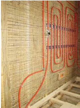
Εικόνα 83 : Ενσωματωμένο σύστημα ενδοτοιχίας θέρμανσης
