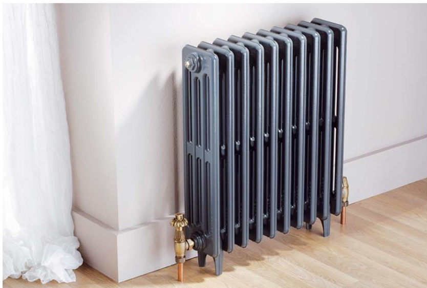
Εικόνα 65 : Θερμαντικό σώμα με παροχή νερού από μονοσωλήνιο σύστημα (είσοδος /έξοδος αριστερά και δεξιά αντίστοιχα)
