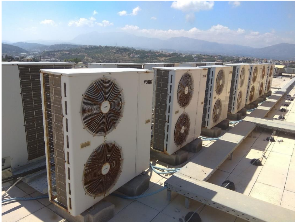
Εικόνα 96 : Αντλίες θερμότητας (40.000 Btu/h έκαστη), μέρος συστήματος VRV
