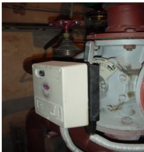
Εικόνα 38 : Τρίοδη βάννα αντιστάθμισης αυτόματης-χειροκίνητη λειτουργίας
