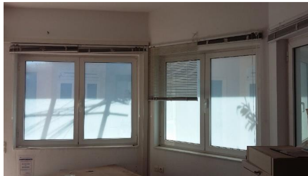
Εικόνα 4.2: Υαλοπίνακες του κτιρίου.
