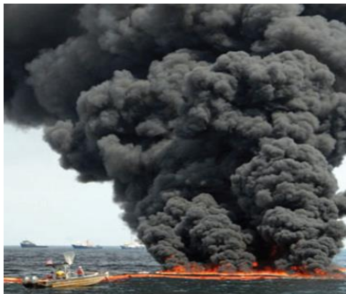
Εικόνα 2.9 η επιτόπου καύση συγκεντρωμένου πετρελαίου που διέρρευσε (πηγή: NOAA)
