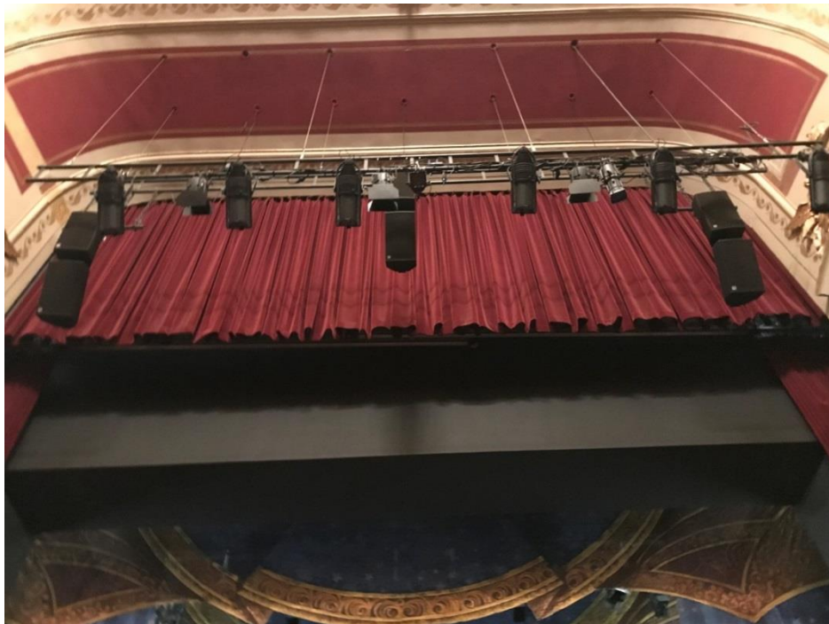
Εικόνα (4.6.7.2) σταγκόνι φώτων και ηχείων
