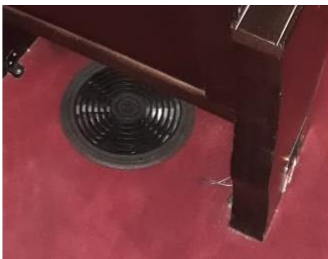
Εικόνα 15 -στόμια κλιματισμού
