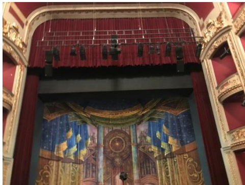
Εικόνα (4.6.7.1) σταγκόνι φώτων και ηχείων
