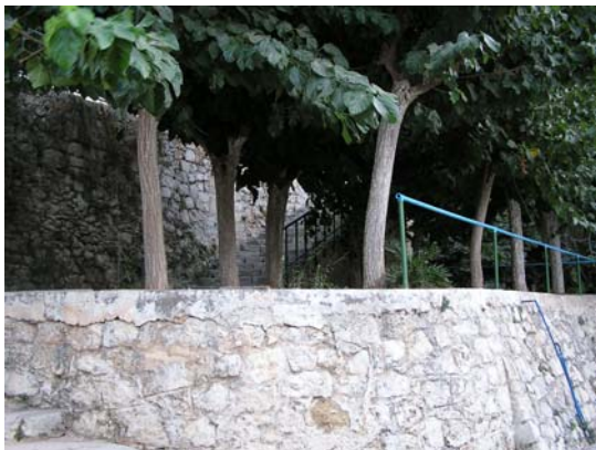
Εικόνα 28. Η είσοδος από τη Γ. Γεωργιάδη. Είναι φανερή η έλλειψη δυνατότητας πρόσβασης για Α.Μ.Ε.Α.
