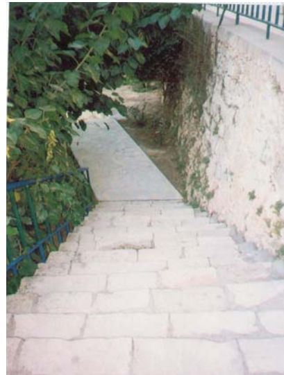
Εικόνα 29. Λεπτομέρεια της εισόδου. Είναι χαρακτηριστική η κλίση της σκάλας.
