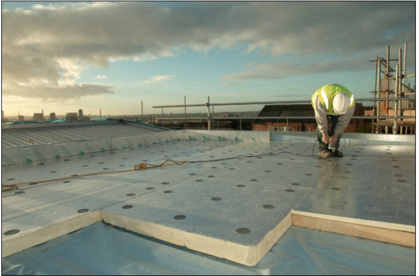
Εικόνα 56 Εργασία τοποθέτησης θερμομονωτικών πλακών σε δώμα
