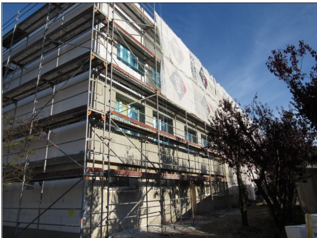
Εικόνα 57 Εφαρμογή Εξωτερικής Θερμομόνωσης σε Κτίριο
