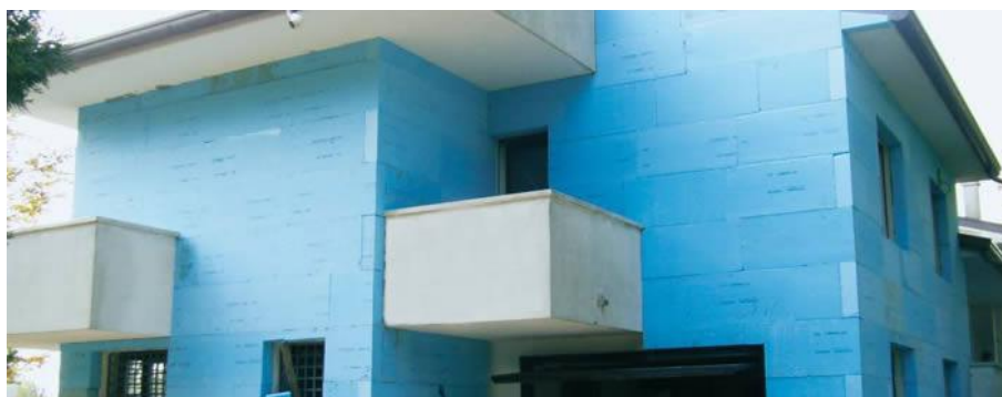
Εικόνα 36: Εφαρμογή μόνωσης σε πρόσοψη κτηρίου
