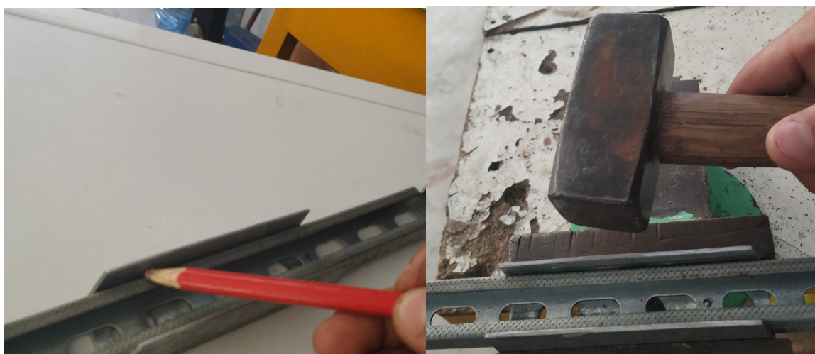
Εικόνα 62: Σημάδεμα και κατασκευή νέων «αυτιών».
