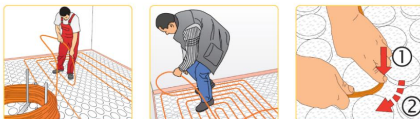
Σχήμα 3.21 : Τοποθέτηση του πολυστρωματικού σωλήνα [6]
