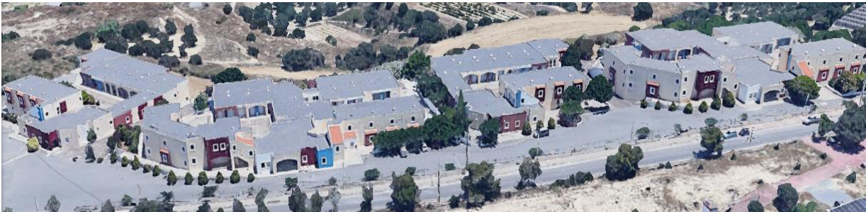
Εικόνα 3.1.1.2: Δυτική Όψη 3D Φοιτητικών Εστιών, εικόνα από δορυφόρο, πηγή: Google Earth
