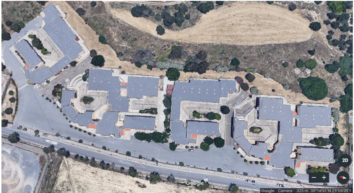
Εικόνα 3.1.1.4: Όψη Δώματος Φοιτητικών Εστιών, εικόνα από δορυφόρο, πηγή: Google Earth
