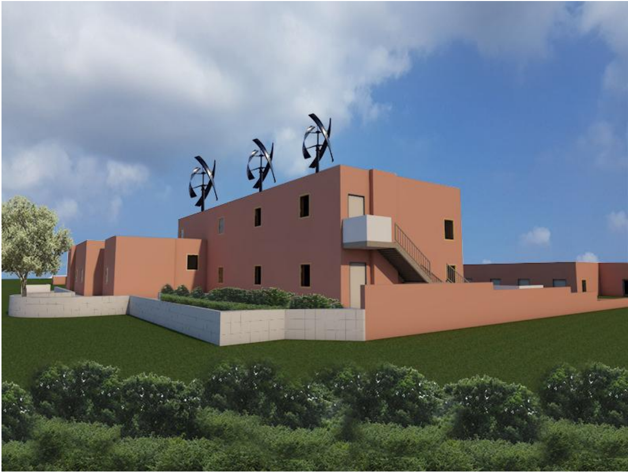
Εικόνα 4.3.1.2: Προσέγγιση εικόνας κτιρίου Γ μετά την τοποθέτηση Α/Γ.
