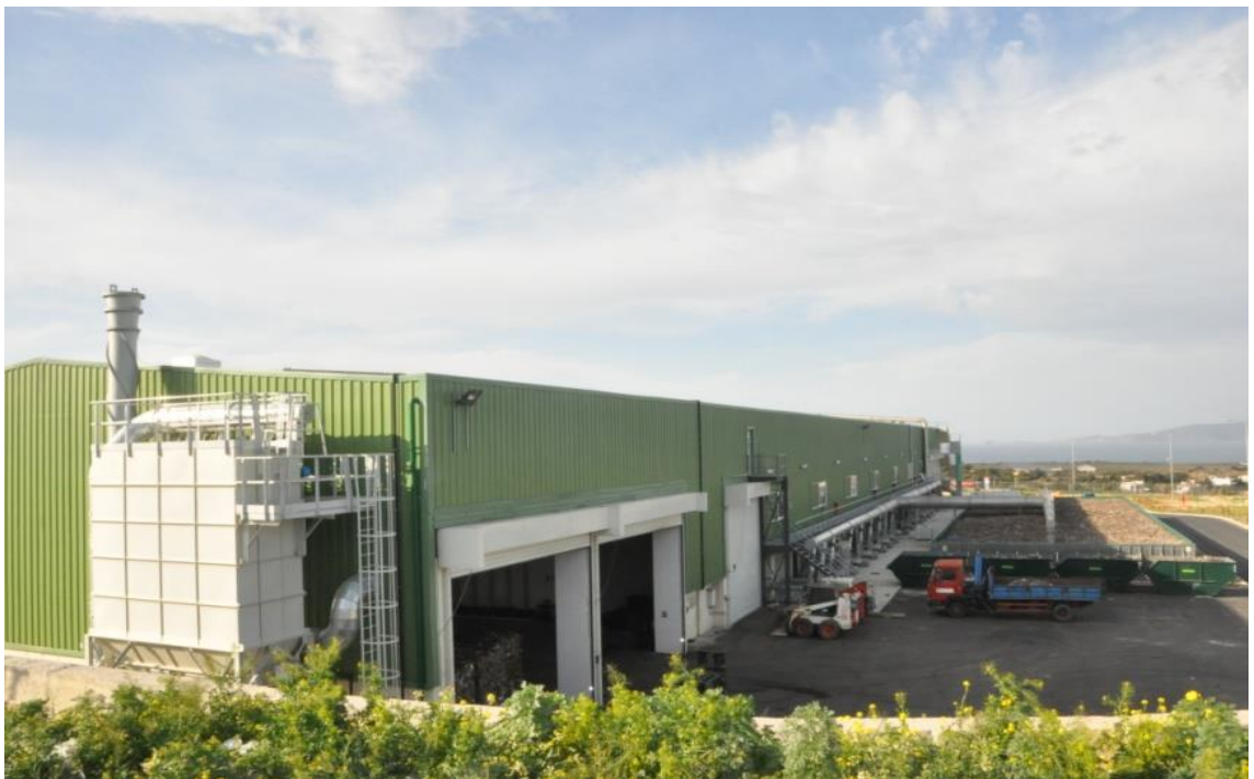
εικ. 8: Η Μονάδα προεπεξεργασίας Απορριμμάτων Ηρακλείου Κρήτης
