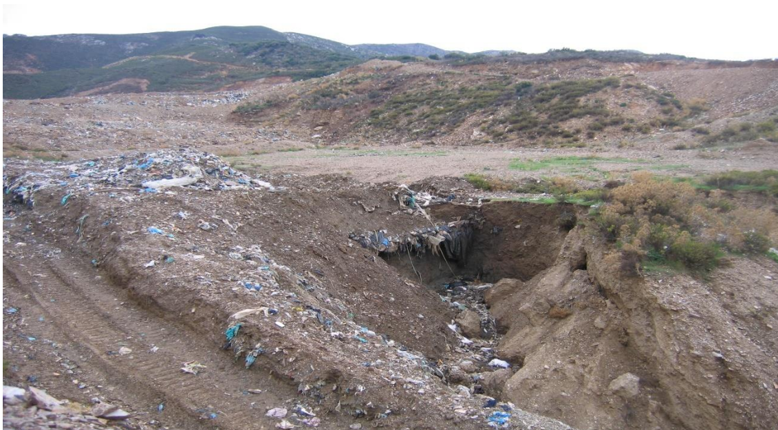
εικ. 25: Καθίζηση απορριμματικού ανάγλυφου στο ΧΑΔΑ Π. Γαλήνων (ΕΣΔΑΚ)
