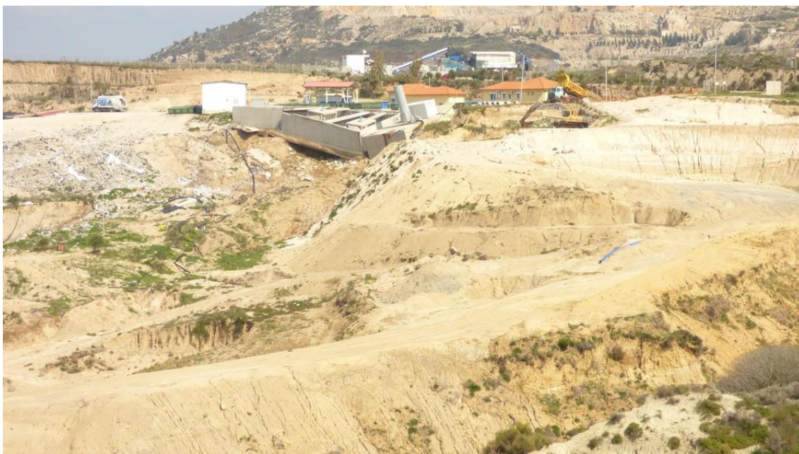
εικ. 11: Κατάρρευση απορριμματικού ανάγλυφου στο ΧΥΤΑ ΚΩ
