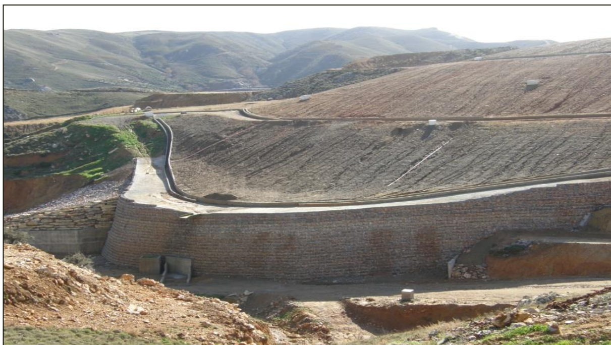
εικ.3: ΧΑΔΑ ΜΑΡΟΥΛΑ Δήμου Ρεθύμνου μετά την αποκατάσταση
