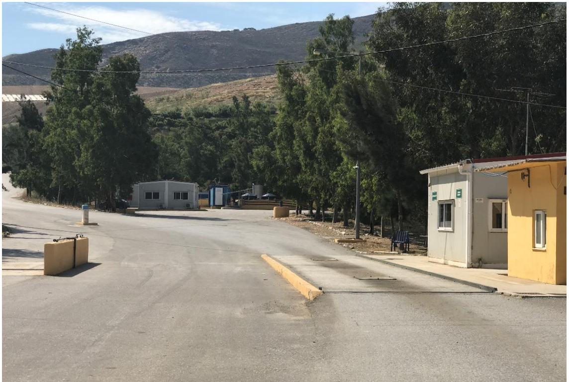
εικ. 31: Άποψη φυλακίου, κτιρίου Διοίκησης, ζυγαριάς στο ΧΥΤΑ Π. Γαλήνων
