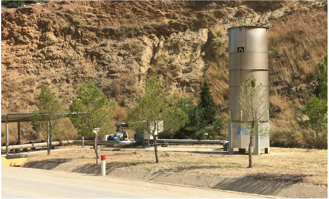
εικ. 33: Άποψη Πυρσού καύσης βιοαερίου στο ΧΥΤΑ Π. Γαλήνων
