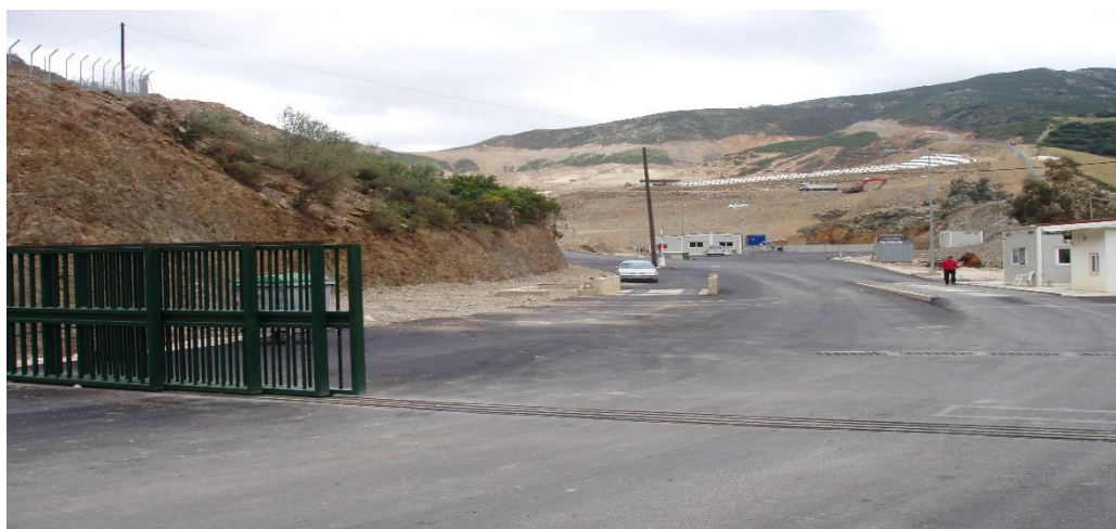
εικ. 24: Εγκαταστάσεις υποδομών στο ΧΥΤΑ Π. Γαλήνων (ΕΣΔΑΚ)
