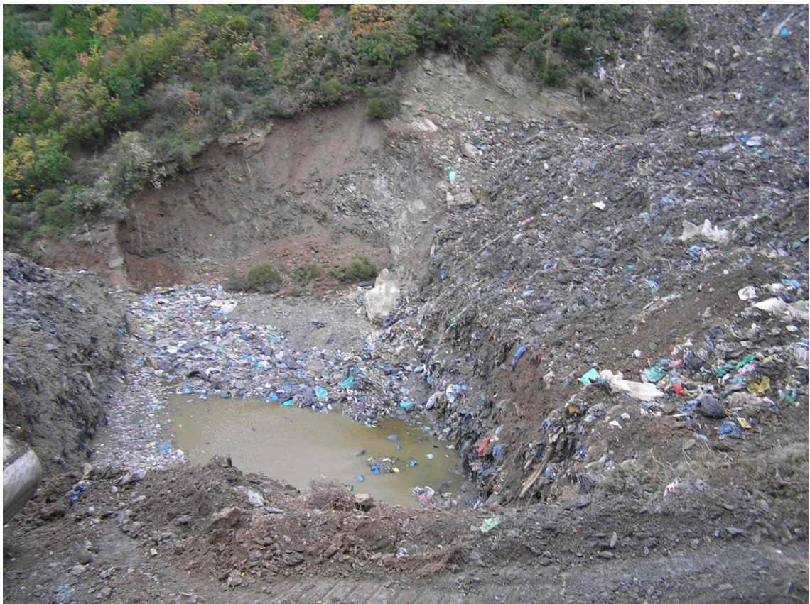
εικ.13: Ανεξέλεγκτη διαφυγή στραγγιδίων
