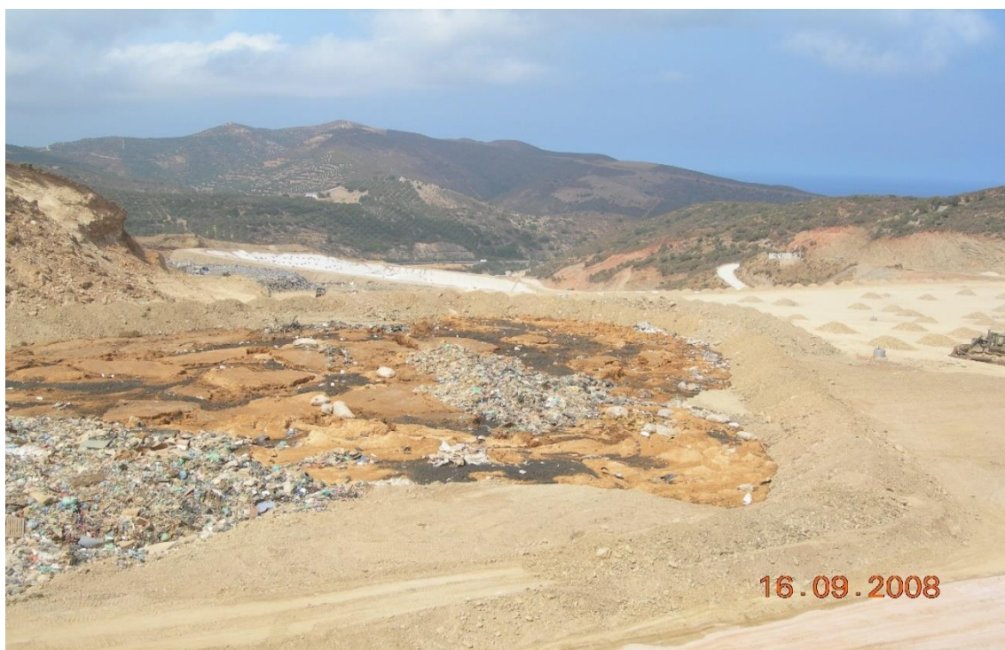
εικ. 18: Εγκλωβισμός υφιστάμενης λυματολάσπης στο ΧΔΑ Π. Γαλήνων (ΕΣΔΑΚ)
