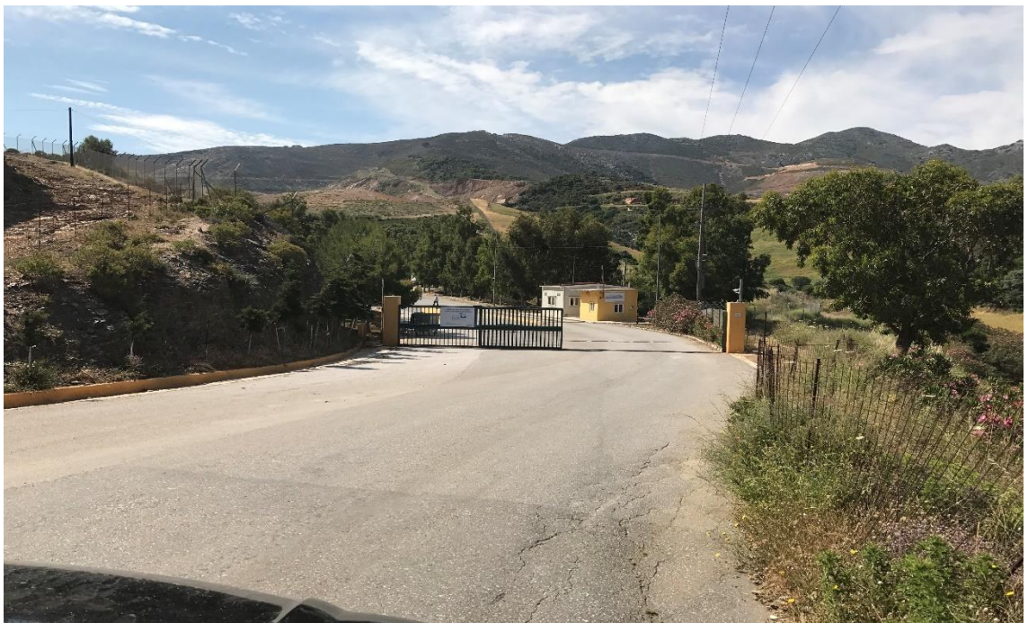
εικ. 30: Άποψη εισόδου στο ΧΥΤΑ Π. Γαλήνων (ΕΣΔΑΚ)
