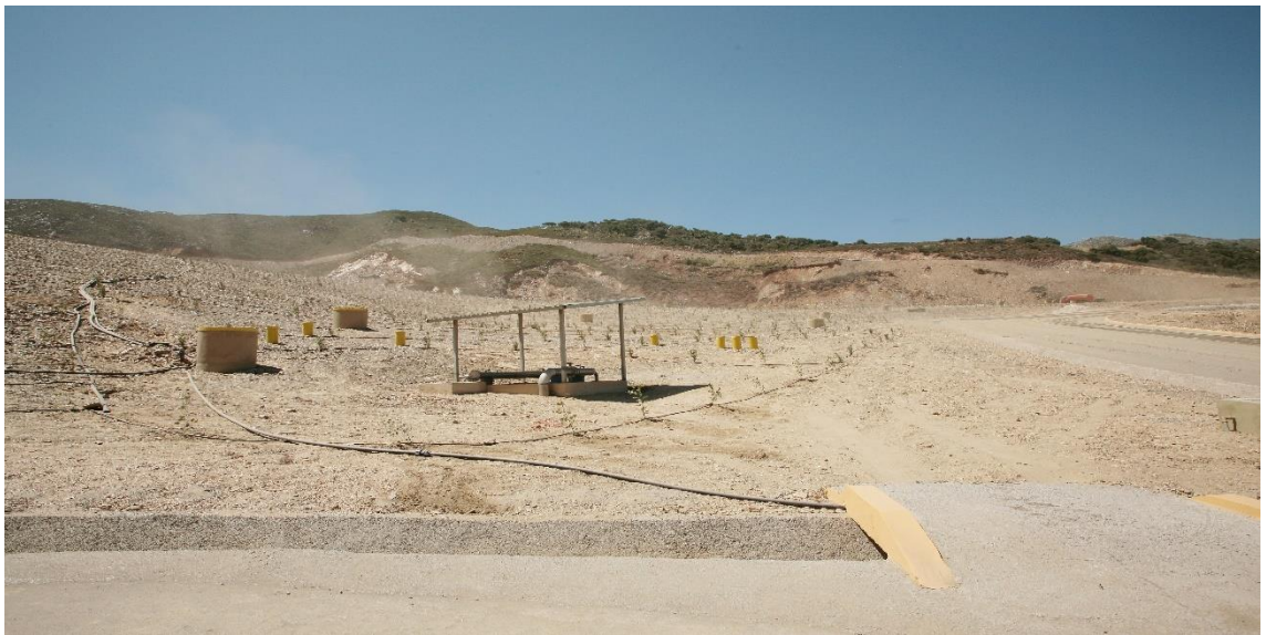
εικ. 22: Δίκτυο συλλογής βιοαερίου στο ΧΥΤΑ Π. Γαλήνων (ΕΣΔΑΚ)
