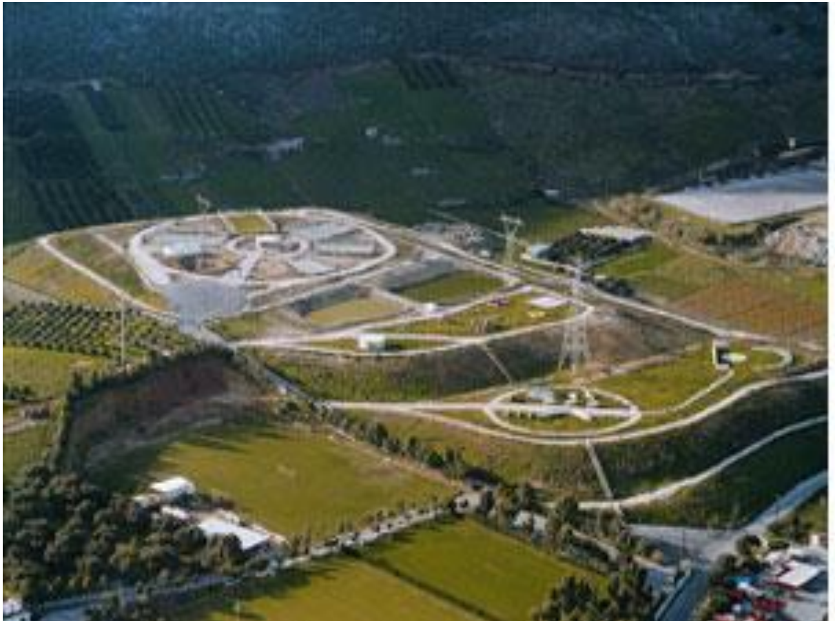
εικ.1: ΧΑΔΑ ΣΚΑΦΙΔΑΡΑΣ Ηρακλείου μετά την αποκατάσταση
