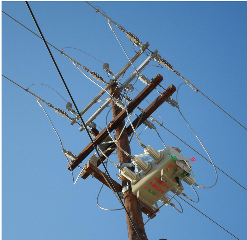
Σχήμα 22. Τυποποιημένη Κατασκευή Στόλου (P-22A) με Διακόπτη Φορτίου.
