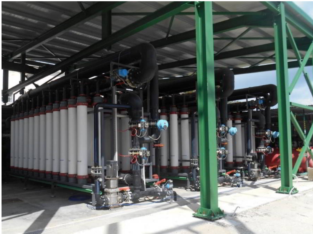
Εικόνα 9: Μемβράνες υπερδιήθησης διυλιστηρίου Σκαλανίου ( https://www.sychem.gr , n.d.)
