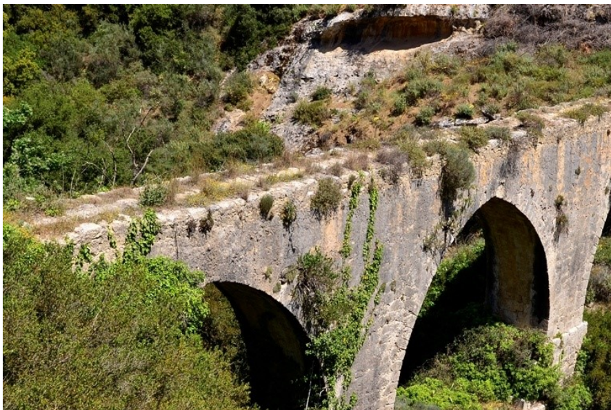
Εικόνα 8: Υδατογέφυρα μήκους 65μ. στο Καρυδάκι ( http://www.archanes-asterousia.gr , n.d.)
