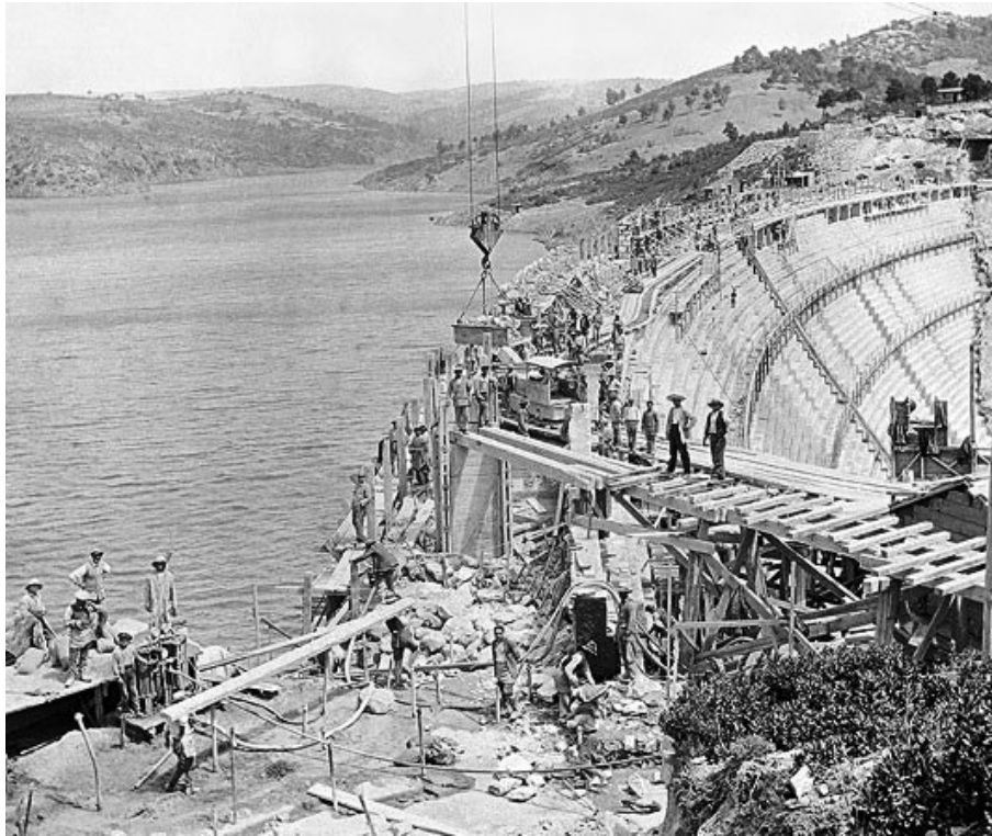
Εικόνα 3: Κατασκευή του φράγματος Μαραθώνα ( http://www.mixanitouxronou.gr )
