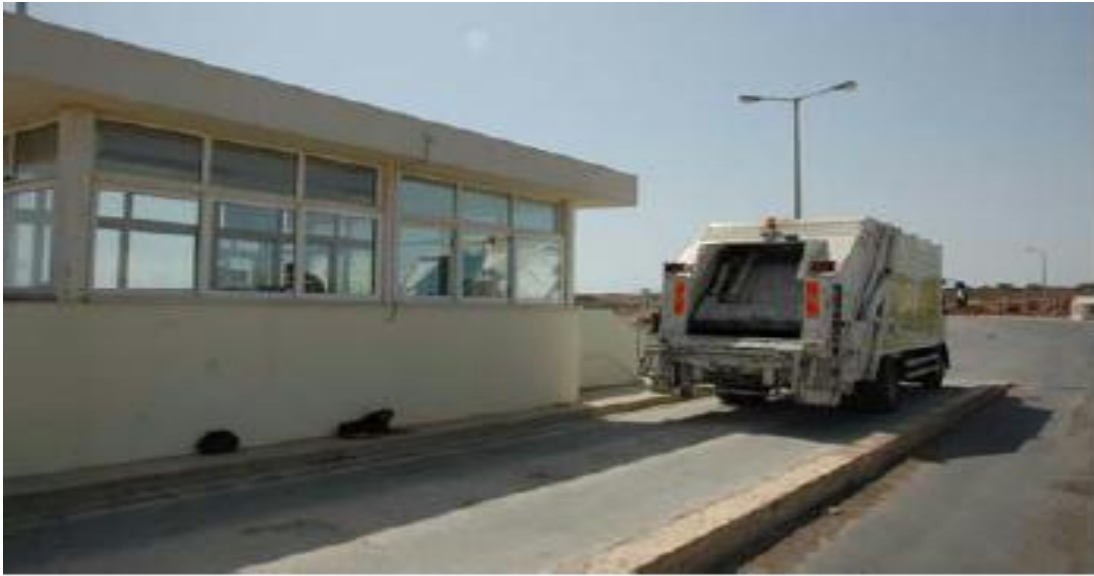
ΕΙΚΟΝΑ 8 Κτίριο Υποδοχής στην ΜΜΔΚ Ν Χανίων
