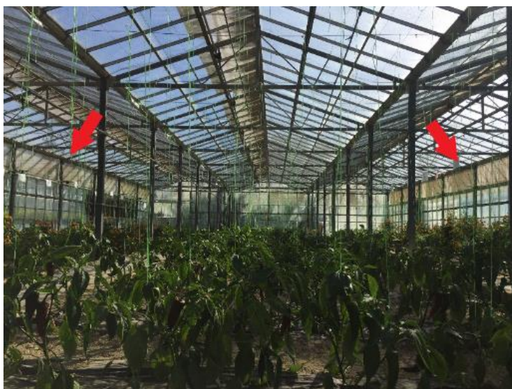
Εικόνα 3.7: Σήμανση παραθύρων με εμφανή εντομοστεγή δίχτυα στο ναλόφρακτο θερμοκήπιο του εργαστηρίου Λαχανοκομίας του ΕΛ.ΜΕ.Π.Α., 2017.
