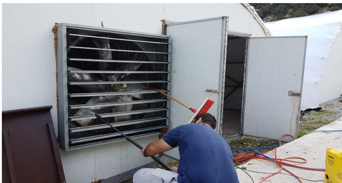
Εικόνα 4: Ο ανεμιστήρας του συστήματος ψύξης κατά τον καθαρισμό του.
