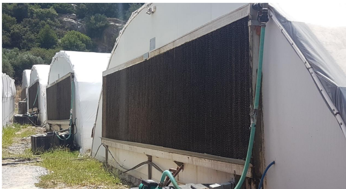
Εικόνα 3: Σύστημα ψύξης καλλιέργειαςμανιταριών τύπου Υγρής παρείας .
