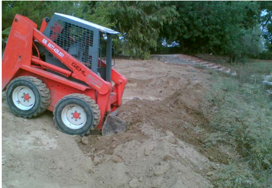
Εικόνα 15. Εσκαφή θεμελίων του αμφιθεάτρου.
