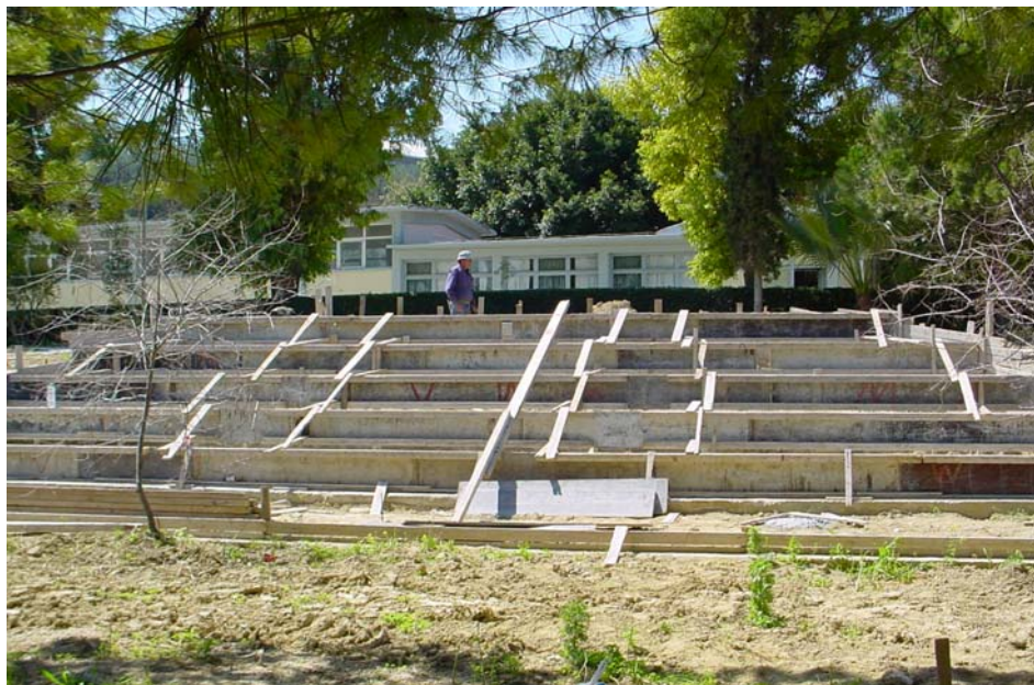
Εικόνα 16. Καλούπωμα αμφιθεάτρου.
