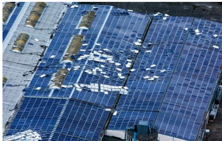
Εικόνα 35 Αποτέλεσμα ρήξης κεραυνού σε φωτοβολταϊκά (Πηγή zoldtrend.hu)
