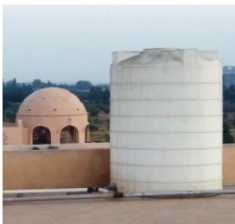
Εικόνα 5 Πλαστική δεξαμενή συλλογής βρόχινου νερού εγκατεστημένη στην Anafora, Cairo (Πηγή: E.Dusingizumuremyi)
