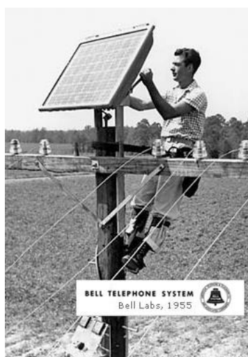
Εικόνα 17 Πρώτη εγκατάσταση πλαισίων (Πηγή www.csisun.com )
