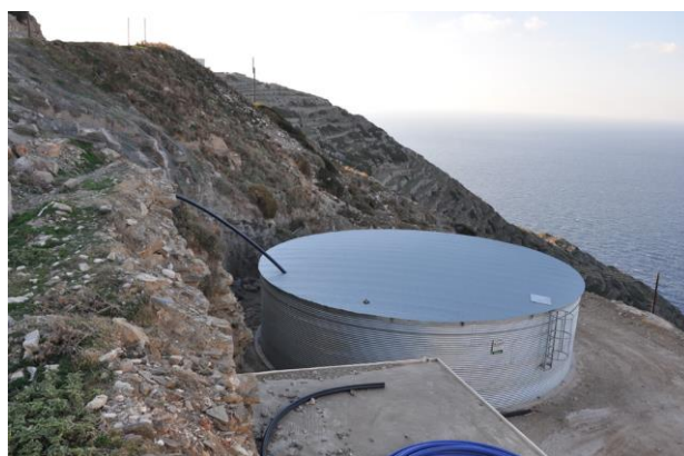
Εικόνα 6 Μεταλλική δεξαμενή που έχει εγκατασταθεί στη Σίκινο (Πηγή: GWP-Med)
