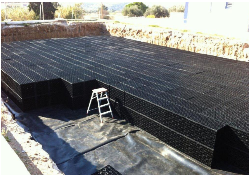
Εικόνα 8 Εγκατάσταση αρθρωτής δεξαμενής στη Σύρο (Πηγή: GWP-Med)
