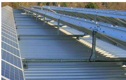
Εικόνα 27 Βάσεις εποχιακά ρυθμιζόμενης στήριξης (Πηγή www.thesolarplanner.com)
