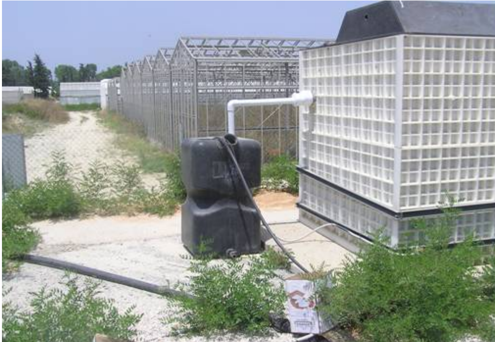
Εικόνα 6. Σύστημα βιολογικής επεξεργασίας με τεχνολογία βιοδίσκων EKOL.
