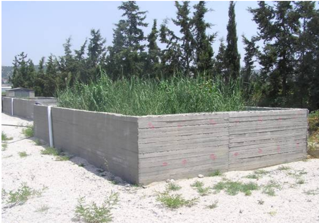
Εικόνα 4. Υγροβιότοπος υποεπιφανειακής ροής (SSF) σε πλήρη λειτουργία.
