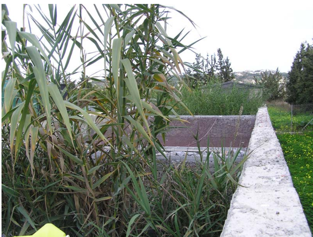
Εικόνα 3. Υγροβιότοπος ελεύθερης επιφανείας (FWS) σε πλήρη λειτουργία
