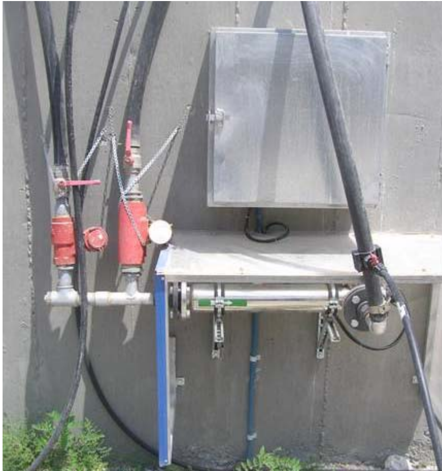
Εικόνα 7. Σύστημα απολύμανσης UV με σκέπαστρο και ροόμετρα
