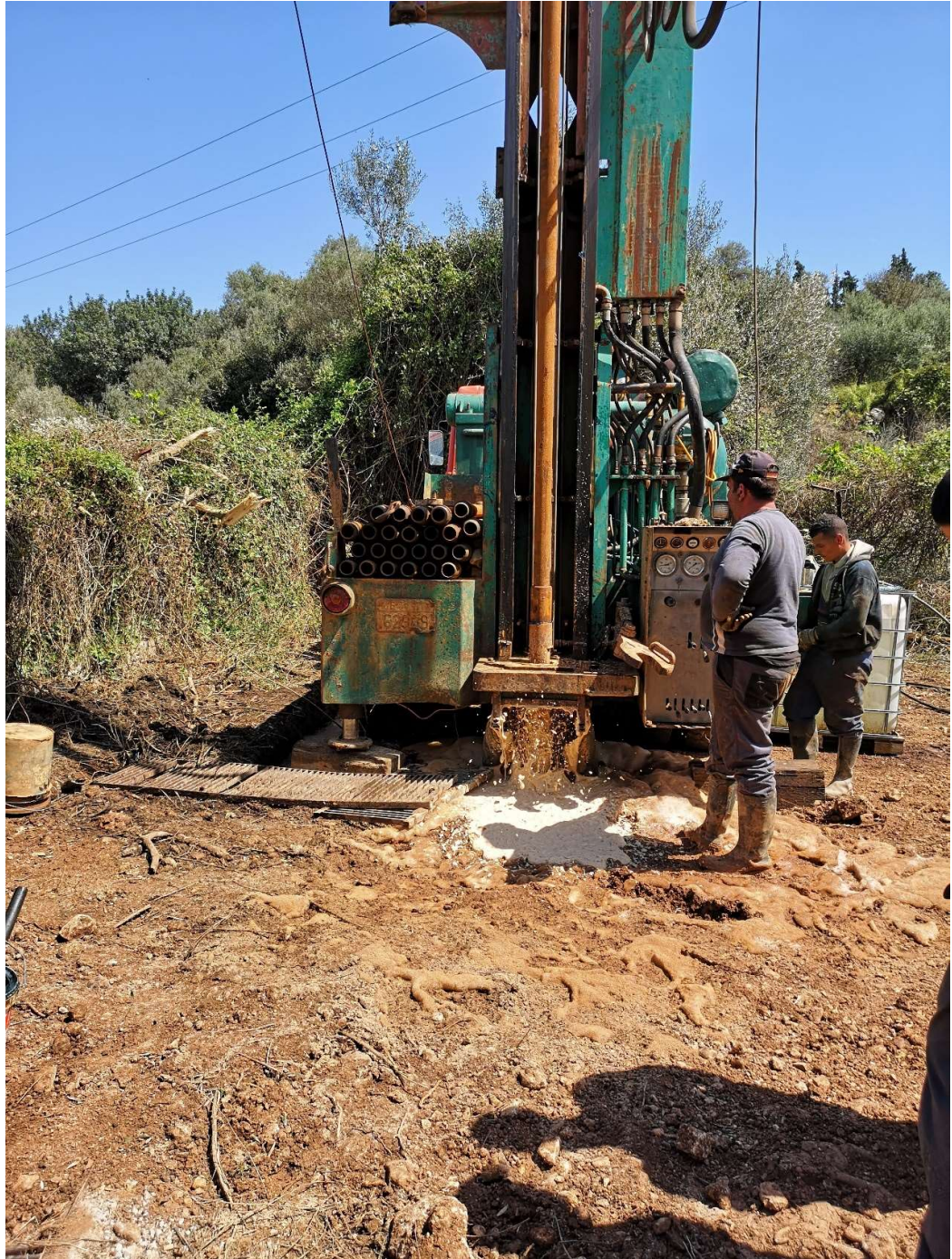
Εκκίνηση κοπτικού εργαλείου , ( ο αφρός που φαίνεται είναι από το κοπτικό εργαλείο ώστε να απομακρύνει τα καπτώσεις από τα τοιχώματα της γεώτρησης).-
