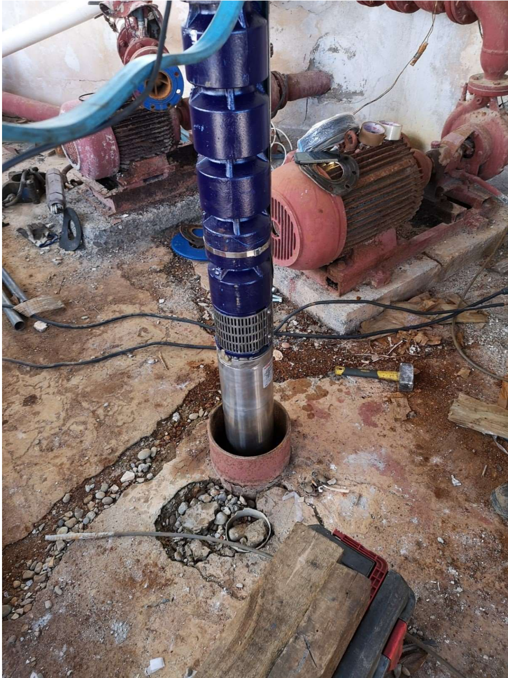
Διάφορα καλώδια τα οποία πρέπει να εφαρμόζουν πάνω στην αντλία ,έτσι ώστε να μην κινδυνεύουν να κοπούν.
