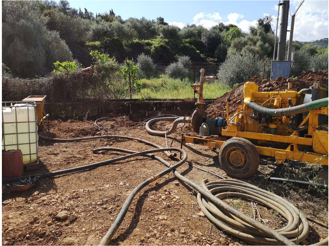
Εγκατάσταση για μπετονίτη διότι υπήρχαν πολλές καταπτώσεις λόγω κροκαλοπαγούς υποστρώματος.
