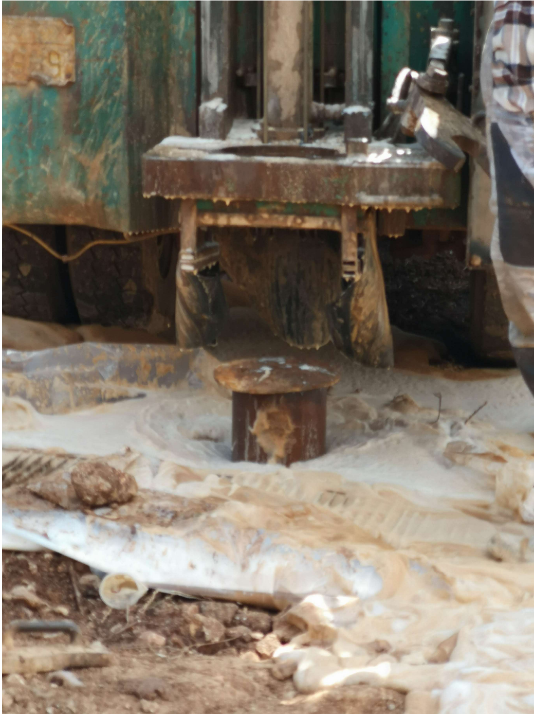
Με την βοήθεια του σίδηρου που τοποθετήθηκε πάνω από την περιφραγματική σωλήνα ο γερανός που φέρει το κοπτικό έσπρωξε την περιφραγματική σωλήνα ακόμα πιο βαθιά από την αρχική της θέση.
