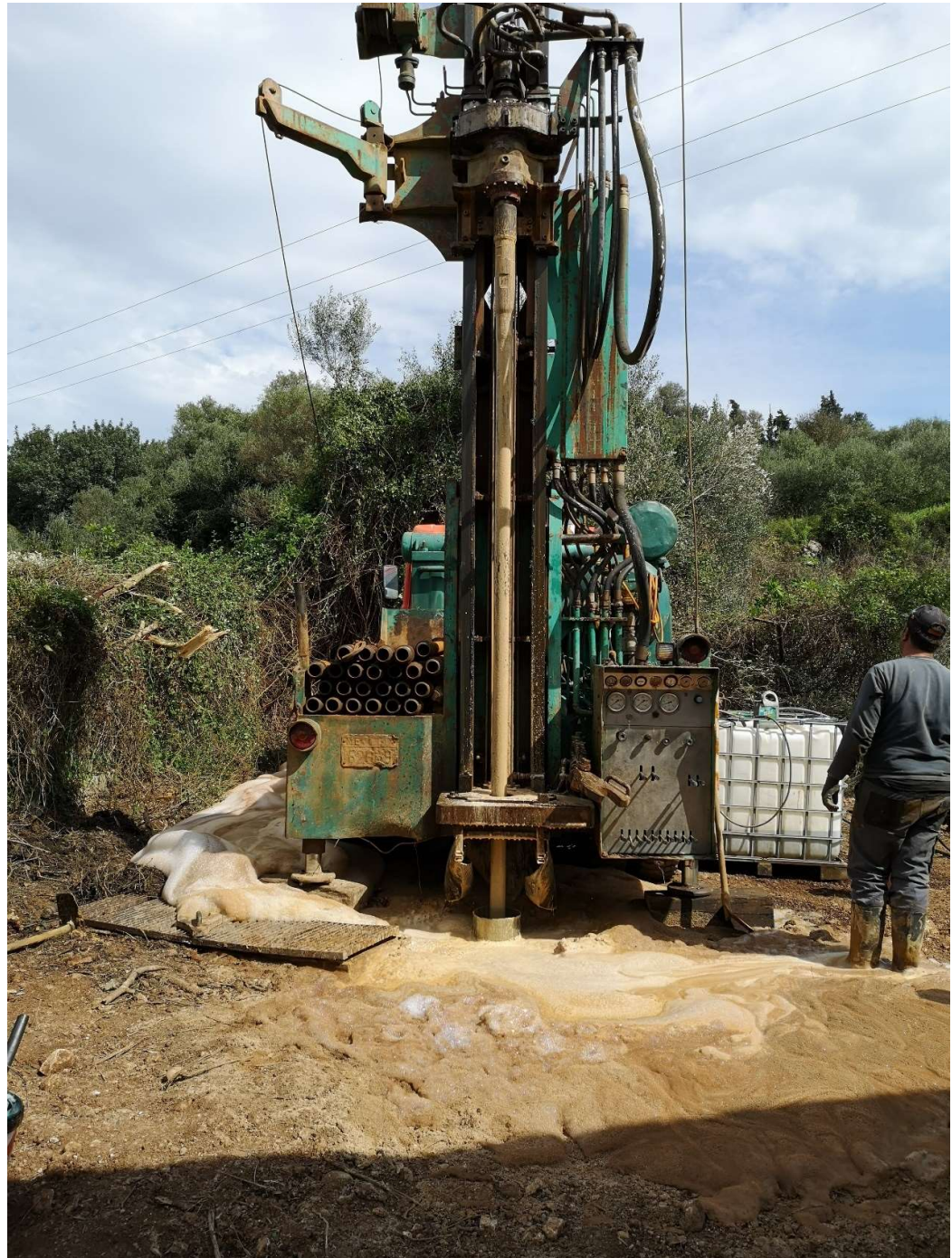
Ο αφρός που βρίσκεται στο πάτωμα είναι από την γεώρτηση που φέρει το υλικό από τις κατώσεις στην επιφάνεια έτσι ώστε να μην φράξει.
