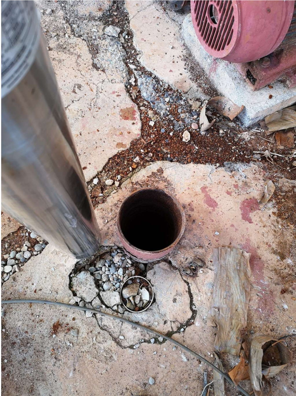
Αυτή είναι η γεώτρηση η οποία πρέπει να κατέβει η αντλία.
