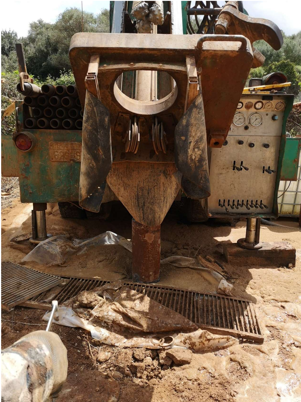
Αποκατάσταση του σπασμένου ρουλεμάν.
