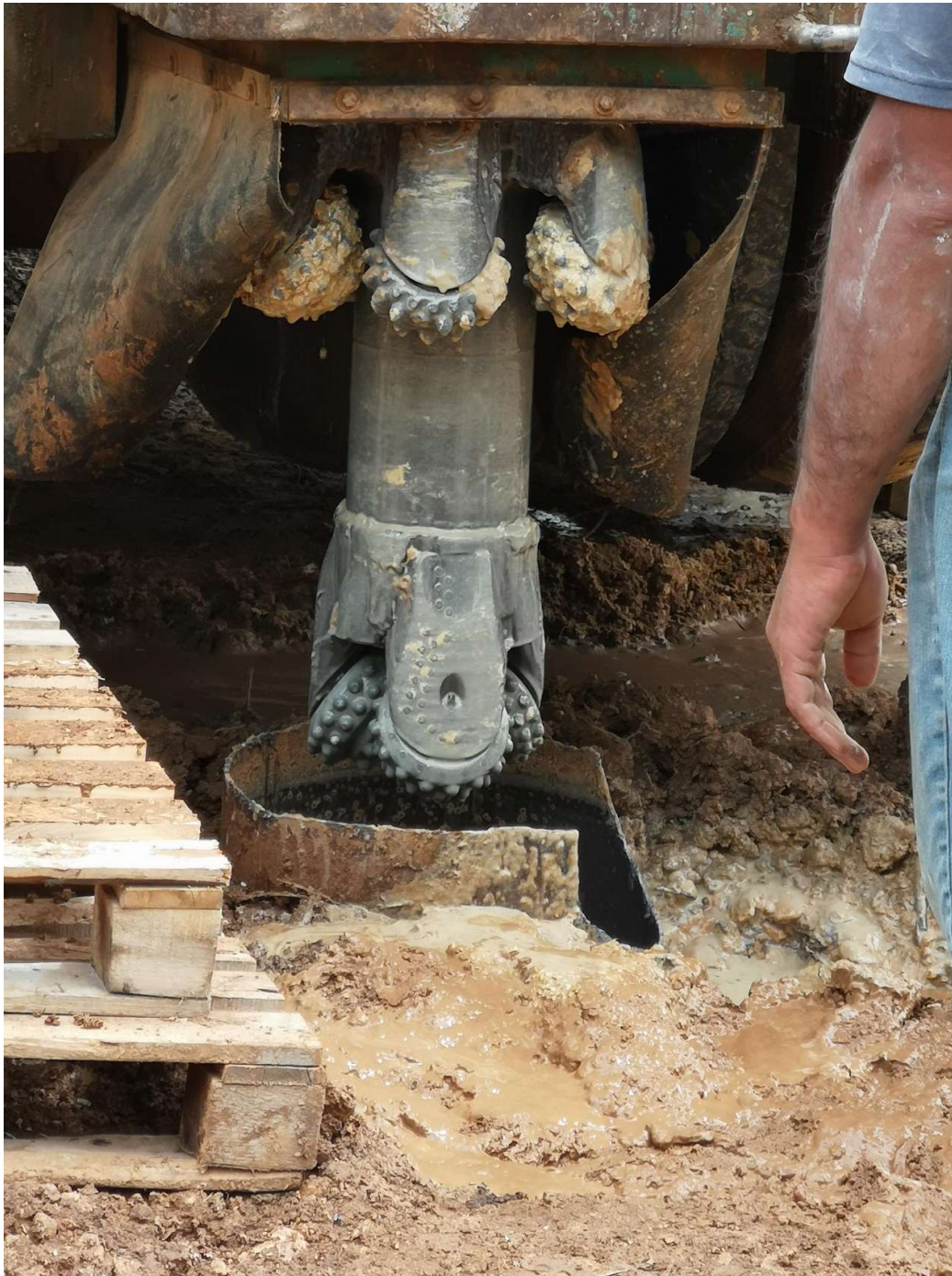
Κοπτικό εργαλείο μεγαλύτερης διατομής(18 ίντσες) από το προηγούμενο, φέρει πάνω του και οδηγό για να μην υπάρχουν μεγάλες αποκλίσεις στην ακτίνα της οπής.
