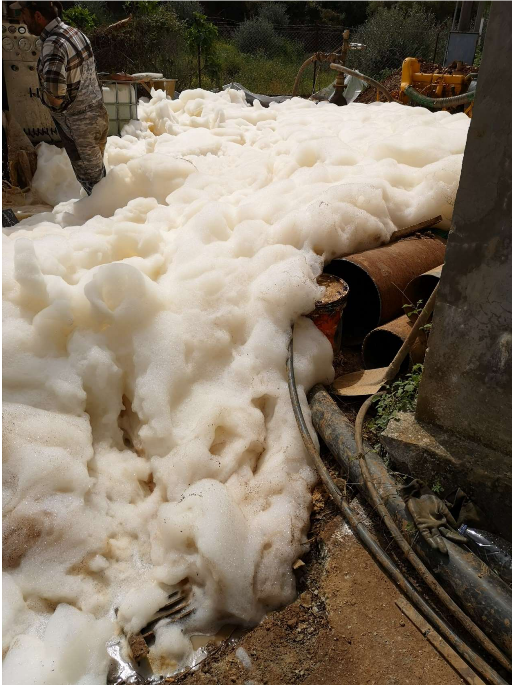
Στα 50 μέτρα βάθος περίπου βρέθηκε νερό ποσότητας περίπου 60 κυβικών μέτρων την ώρα, γι' αυτό το λόγο υπήρχε αυξημένη ποσότητα αφρού.
