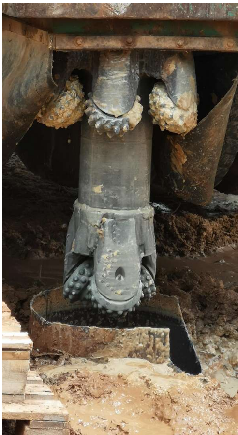
Κοπτικό εργαλείο από την γεώτρηση του Στόλου, υπό την επίβλεψη της Δ.Ε.Υ.Α.Χ
