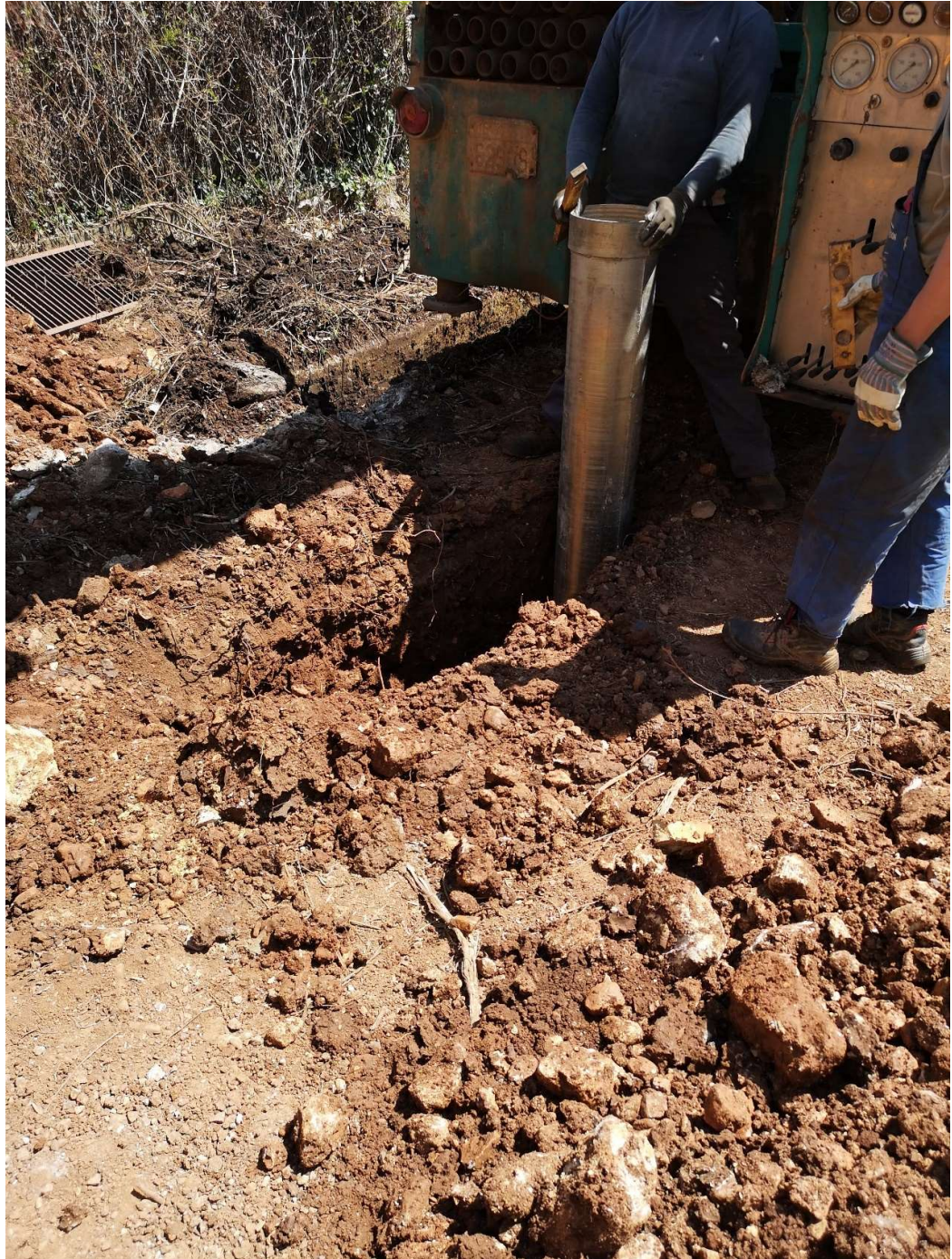
Τοποθέτηση περιφραγματικού σωλήνα.
