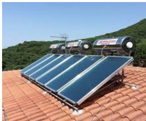
Εικόνα 6, Τοποθετημένοι ηλιακοί συλλέκτες σε στέγη
