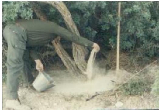
Εικόνα 2-2 Ισοπέδωση του εδάφους με ανθρακικό ασβέστιο
