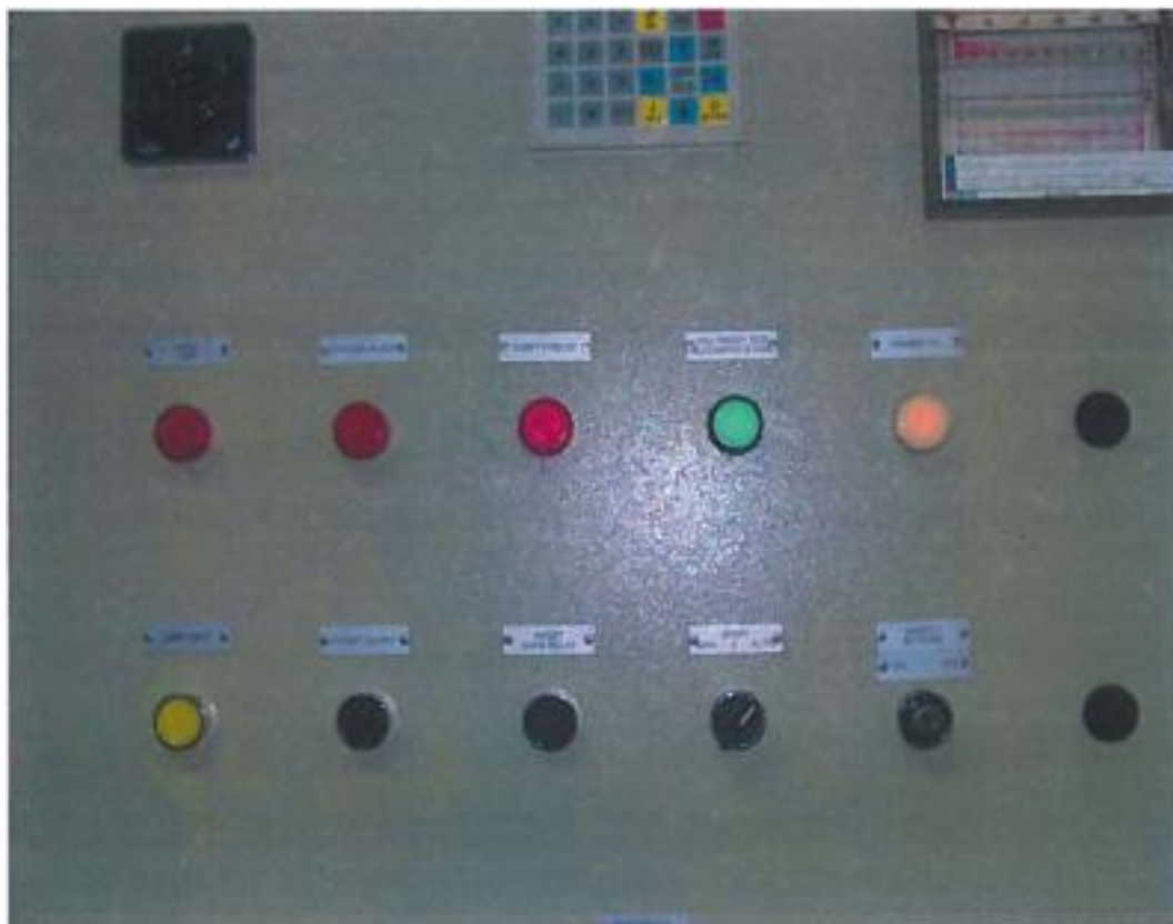
Σχήμα 4.4 Πίνακας της Μονάδας Ανάκτησης Ατμών (Vapor Recovery Unit – VRU) στον πίνακα ελέγχου [60]
