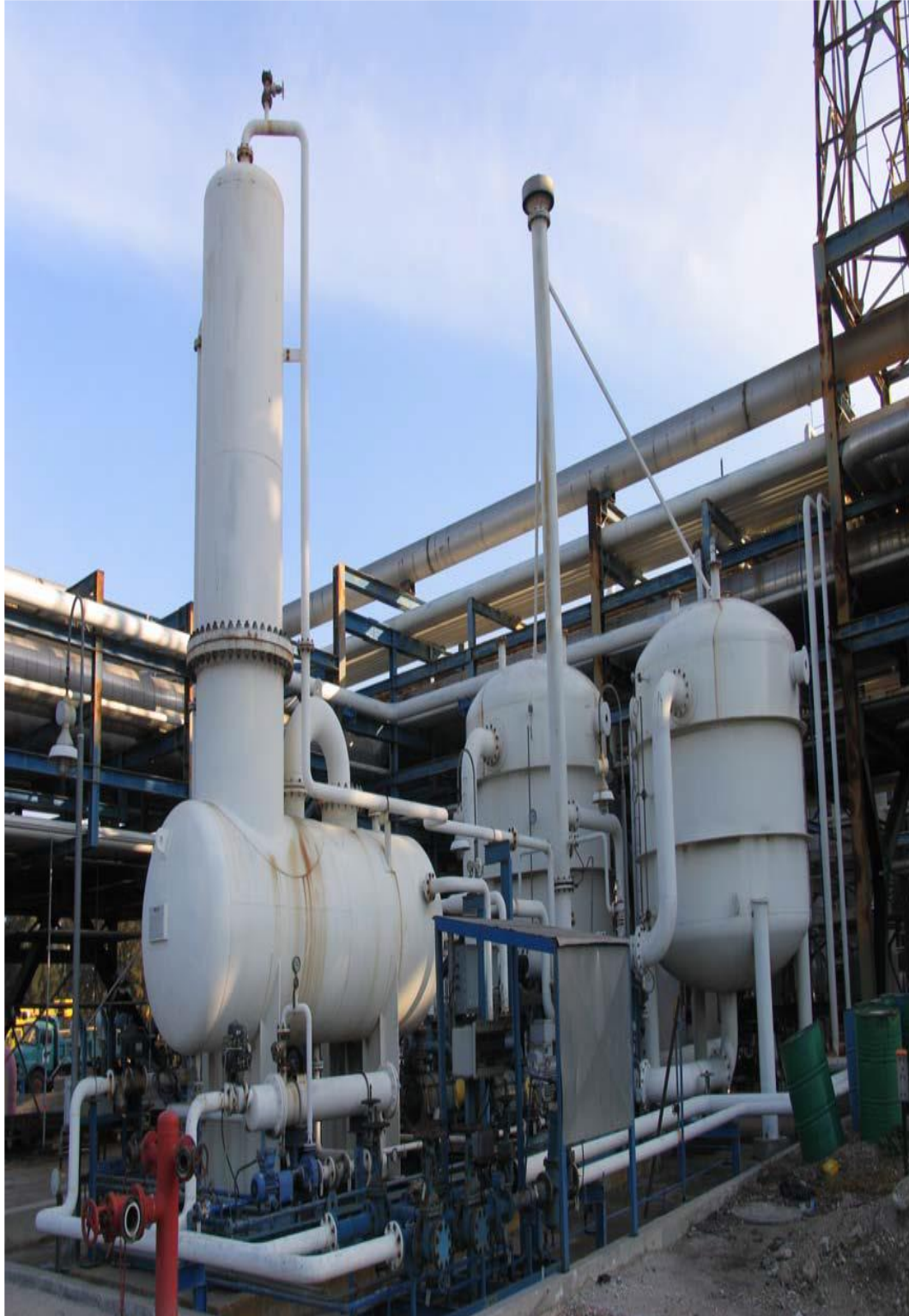
Σχήμα 4.1 Μονάδα Ανάκτησης Ατμών (Vapor Recovery Unit – VRU) [60]
